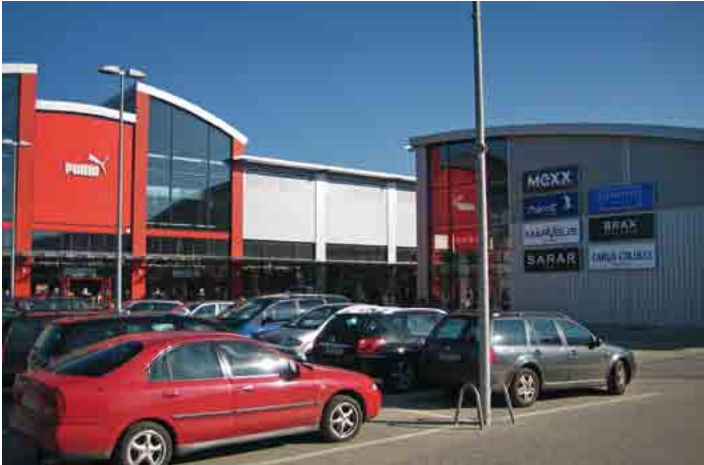
Ochtum Park mit Factory Outlets auf dem Gelände eines ehemaligen Gewerbebetriebes vor der Stadtgrenze Bremen
