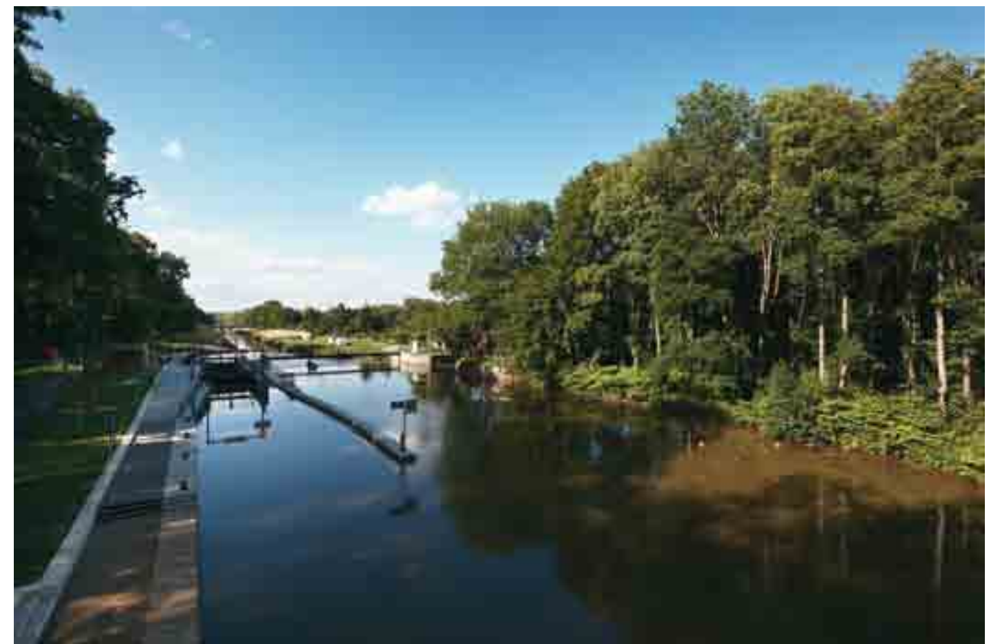
Neue Schleuse im Leipziger Stadtteil Connewitz
