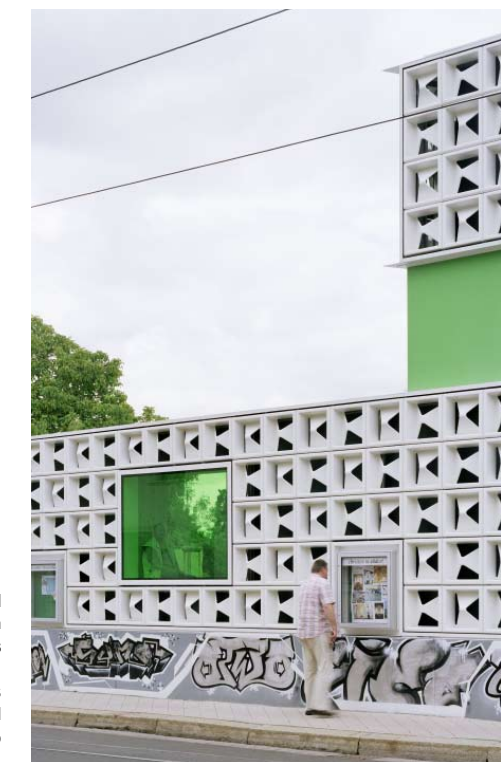
In der äußeren Fassade sind gläserne Aluminiumvitrinen eingelassen, die als Info-Boards des Stadtteils dienen. Aluminium-framed glass display cases are incorporated into the façade to serve as info boards for the district.
