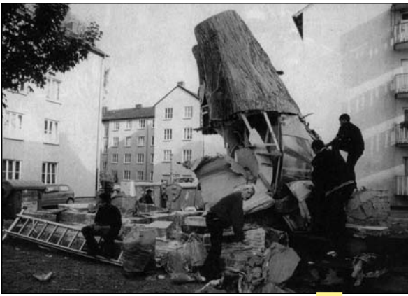
Abb. 2 Bataille Monument im Abbruch (xxx)
