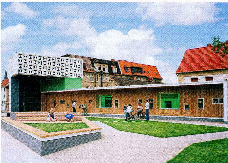
Bücher leihen und lesen, in Räumen oder unter freiem Himmel: Mitten im Zentrum von Magdeburg-Salbke steht dieses gebaute „Lesezeichen“.
