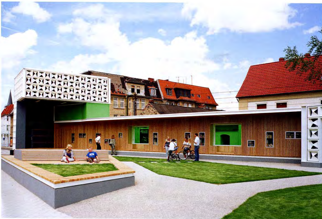
Das «Lesezeichen» in Salbke-Magdeburg mit Blick von der Blumenbergerstrasse, Freiluftbibliothek und Treffpunkt, von KARO-Architekten, 2009.
