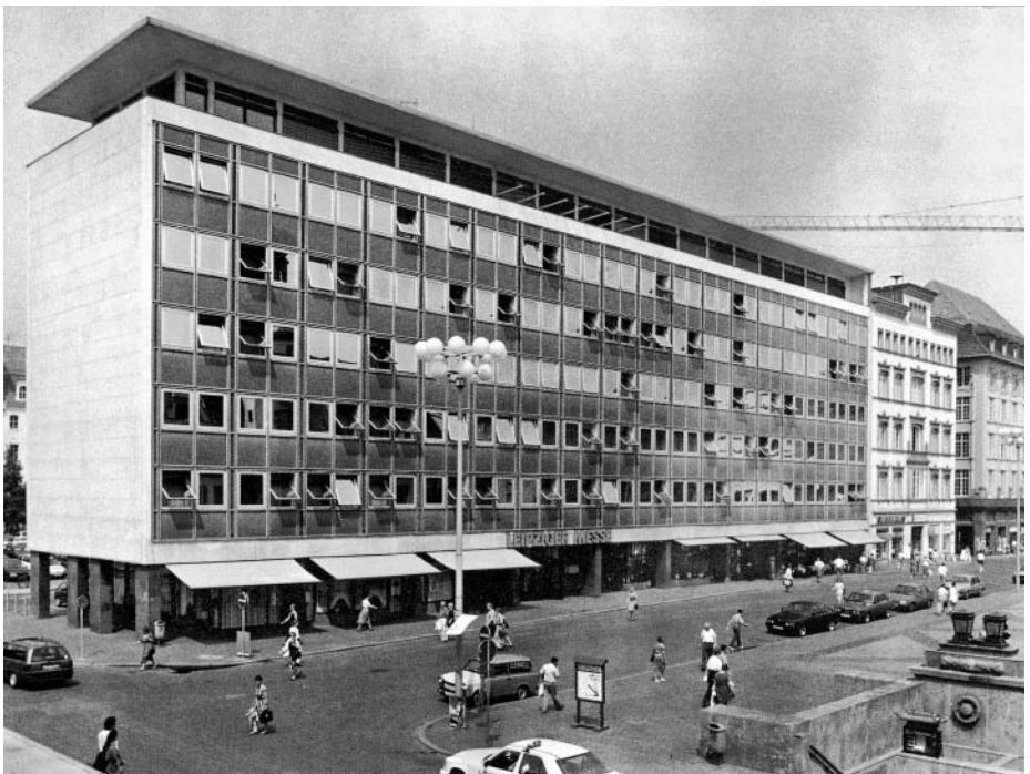
Die Gebäude des Wiederaufbau zeigten, wie sich städtebauliche und architektonische Leitbilder innerhalb weniger Jahre wandelten. Oben das Messehaus (1961–63), unten das Messeamt (1963–65).
